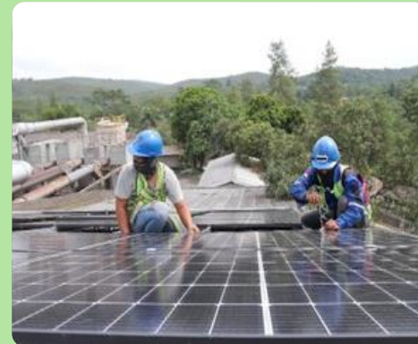
Pemasangan Solar panel
